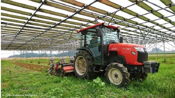
営農型太陽光発電設備
